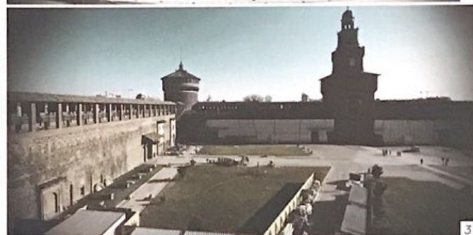
Dall'alto, un dettaglio di Piazza San Pietro (fig. 1), dove Italiana Costruzioni è attualmente impegnata per il restauro, così come in alcuni spazi del Castello Sforzesco (fig. 3); nella Capitale l'azienda ha anche realizzato il Maxxi (fig. 2), Museo per le arti del XXI secolo. Nell'altra pagina la Villa Reale di Monza
