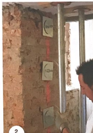
FOTO 3. Le piastre sono state trattate con la resina EPOJET.
