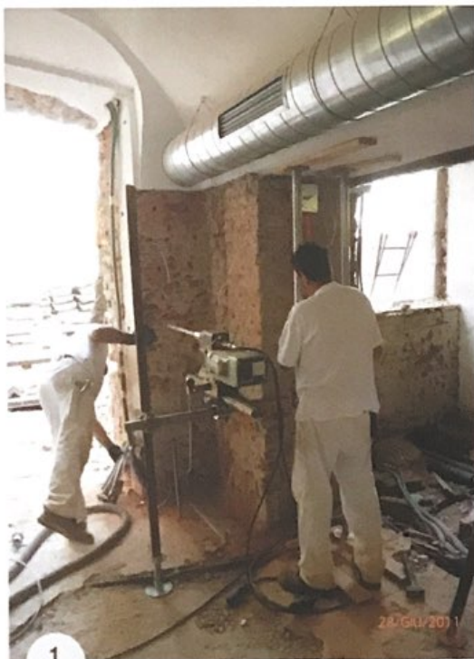
FOTO 1. Perforazioni orizzontali per il passaggio delle barre in acciaio.
